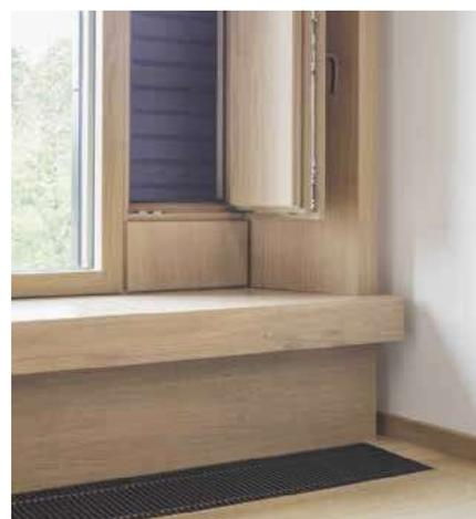
Dezentrale Lüftungsgeräte im Doppelbodenarbeiten im Zu- und Abluftbetrieb und benötigen nur eine Fassadenöffnung.
