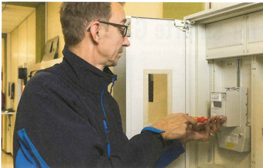
Einbau einer modernen Messeinrichtung bei den Stadtwerken Bayreuth.
