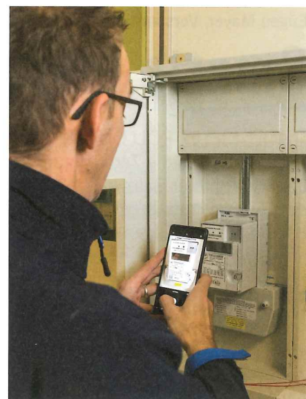
Wenn der Vorgang abgeschlossen ist, wird der Einbau via Smartphone und Workforce-Management-App dokumentiert.
