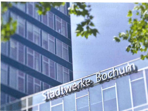
Stadtwerke-Tochter Glasfaser Bochum nutzt Breitband-Netz-Management von Vivax Solution.
