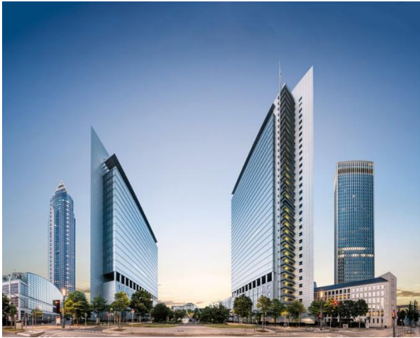
Die Büroetagen des 95 m hohen Gebäudes Kastor (zweites Hochhaus von links) werden dank Sanierung der RLT-Anlagen nun energieeffizienter und hygienischer mit konditionierter Luft versorgt. (Bilder: Condair GmbH)
