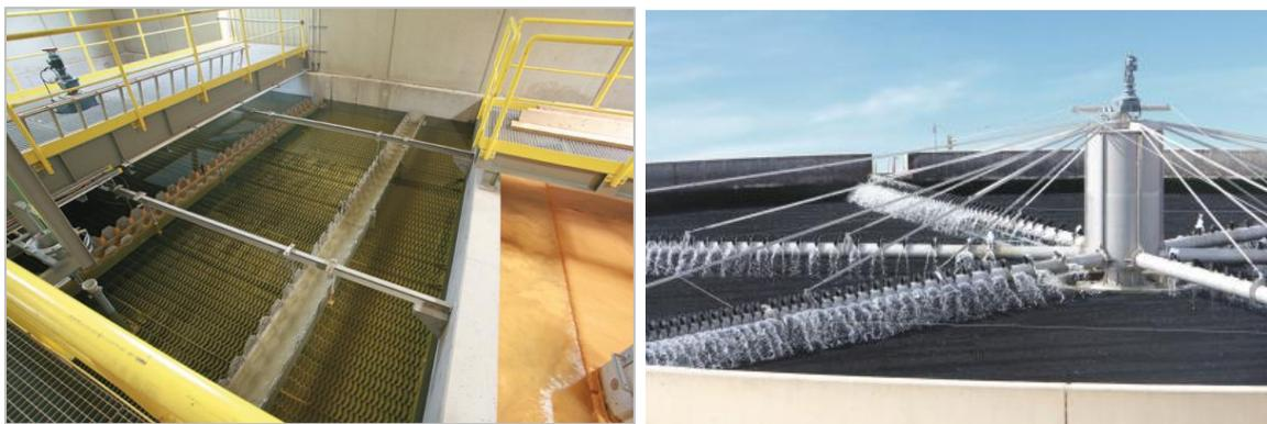
*Absetzbecken in Kraftwerk (linkes Bild) und Tropfkörper-Kläranlage im Mittleren Osten (Bilder: ENEXIO Water Technologies)*
