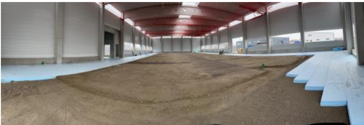
Nach Fertigstellung des neuen Logistikzentrums werden das Lager sowie Warenannahme und Versand hier einziehen. Das schafft Platz in der Werkshalle für eine weitere Fertigungslinie – und somit für einen höheren Durchsatz an varmeco-Produkten. (Bilder: varmeco)
