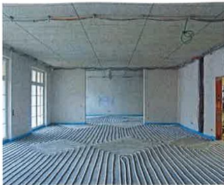
Fußbodenheizung vor der Estrichverlegung (links) und nach der Bodenverlegung (rechts) mit Parkett
