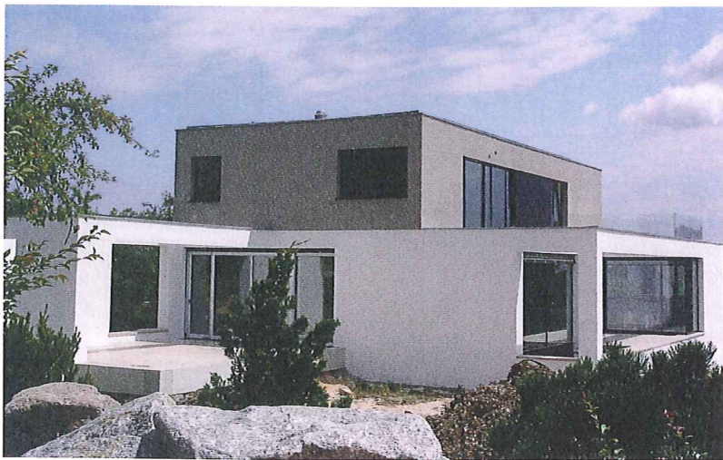
Das am Hang gelegene Einfamilienhaus wurde für eine möglichst autarke Energieversorgung ausgelegt
