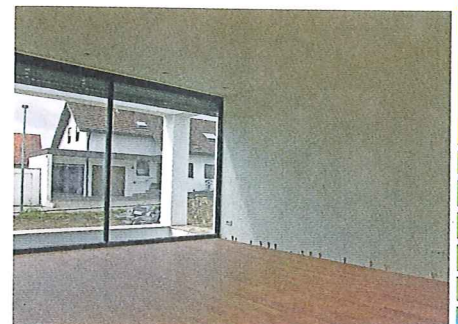
Das fertige Wohnzimmer nach Verlegen des Fußbodens
