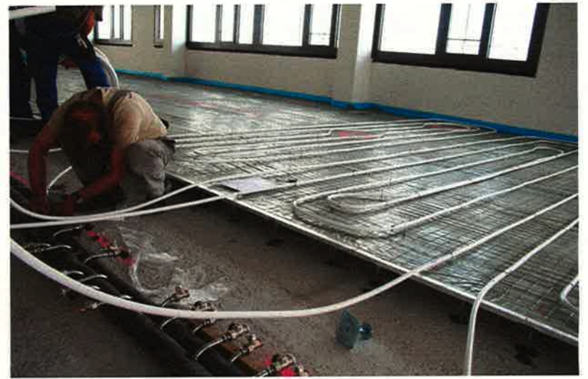
Dank der Materialeigenschaften von Kupfer in Bezug auf die Wärmeleitung erfolgt die Temperierung sowohl im Heiz- als auch im Kühlmodus mit vergleichsweise geringem Energieaufwand.
