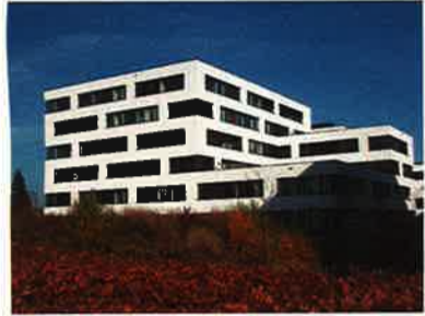
Das Behr-System ist eine Alternative zur thermoaktiven Decke, wobei die Fußbodenkühlung zum Erreichen der (niedrigeren) Raumtemperaturen eine circa 15 Prozent geringere maximale Kälteleistung benötigt, wie der Bürokomplex Step 8.2 zeigt.
